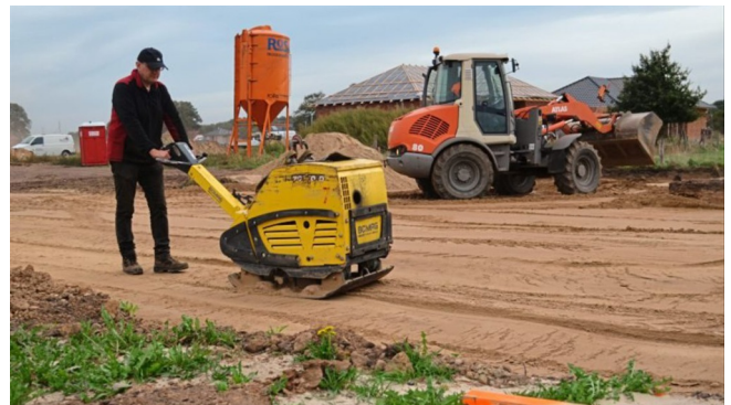
Im Baugebiet südlich Oldenburger Straße laufen die Arbeiten auf vollen Touren. Ein paar Häuser sind schon im Bau. Foto: Thomas Deeken
